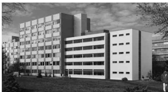
New buildings under construction for Institut für mathematische Stochastik
